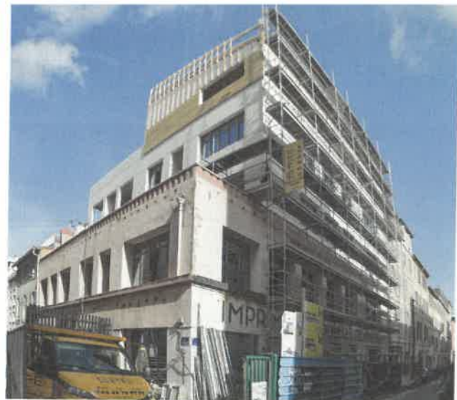
Le bâtiment industriel Imprimerie Nouvelle est surélevé de trois niveaux pour devenir une résidence de grand standing.
